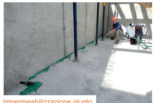
Impermeabilizzazione giunto
