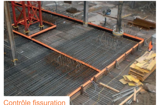
Contrôle fissuration
