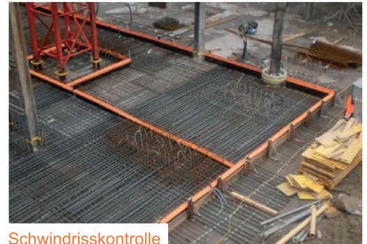
Schwindrisskontrolle
