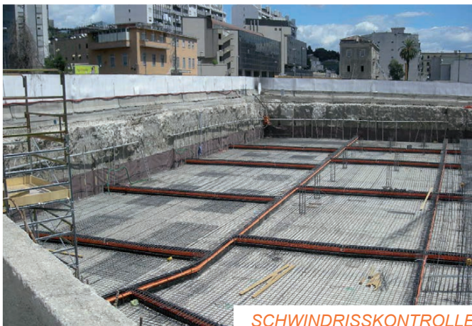
SCHWINDRISSKONTROLLE
