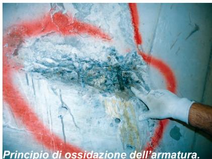
Principio di ossidazione dell'armatura.
