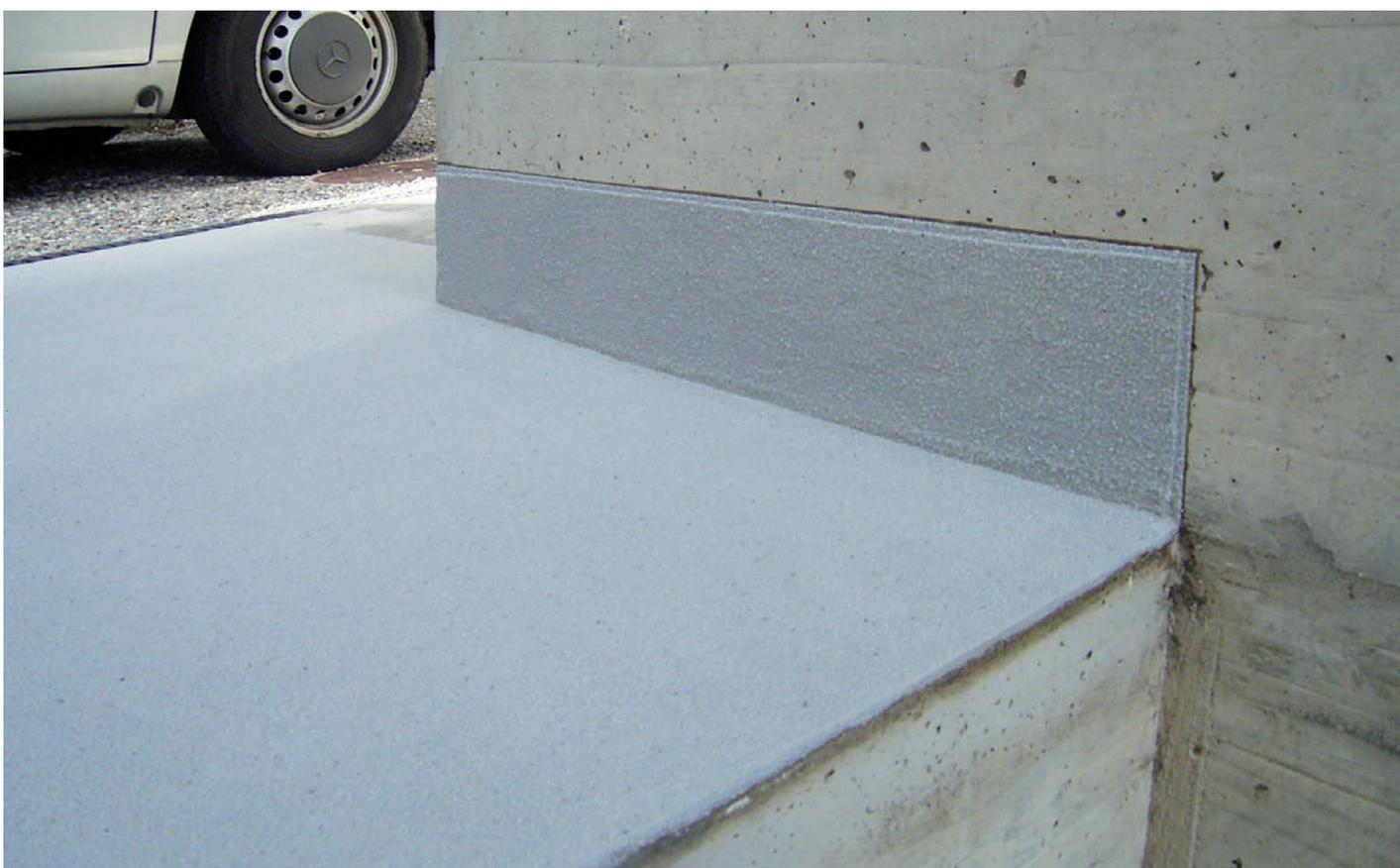
En assainissement, Drycoat se pose directement sur la surface existante, en commençant par les détails. L'étanchéité de la surface est alors liée à celles-ci.
