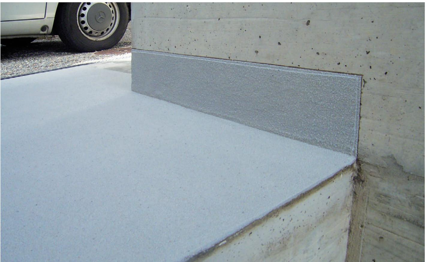
Bei Restaurierungsarbeiten wird Drycoat direkt auf die vorhandene Oberfläche aufgetragen, angefangen mit den Konstruktionsdetails. Die Oberfläche ist dann wasserdicht und kann mit den Details verbunden werden.
