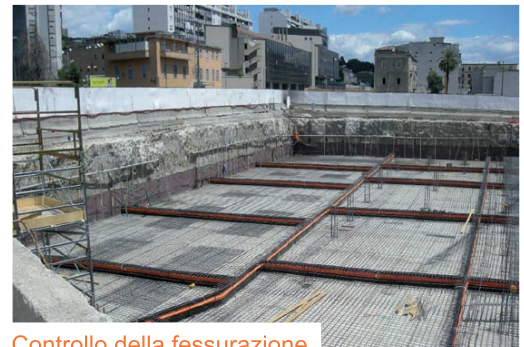
Controllo della fessurazione
