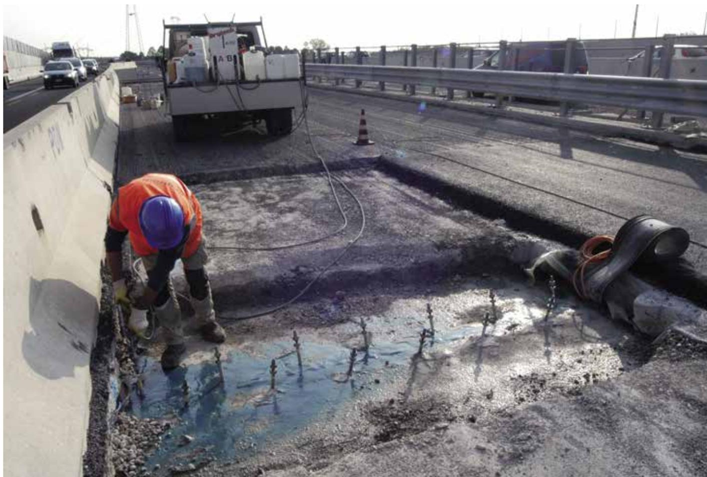
Oltre a essere indifferente alla presenza d'acqua, anche in pressione, la proprietà d'impermeabilizzazione della resina è indipendente anche dallo stato dei giunti che, infatti, non hanno dovuto essere puliti prima dell'iniezione.
