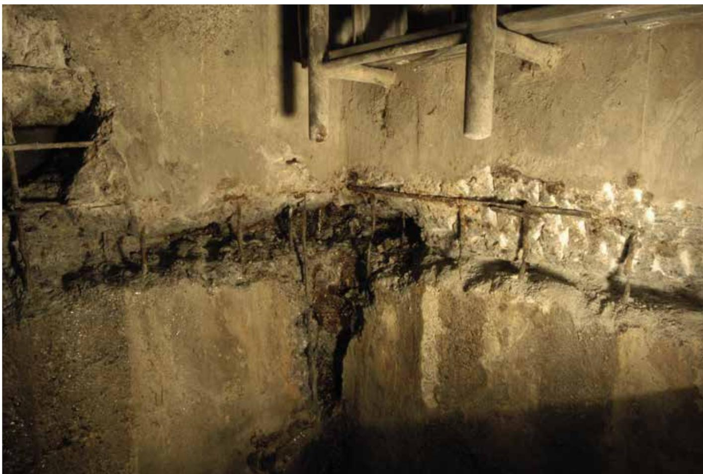
Si è dapprima proceduto all'asportazione del calcestruzzo deteriorato. Quindi sono state impiantate delle canne di scarico per abbassare la pressione dell'acqua, prima di procedere alla ricostruzione della parete con cemento a presa rapida.
