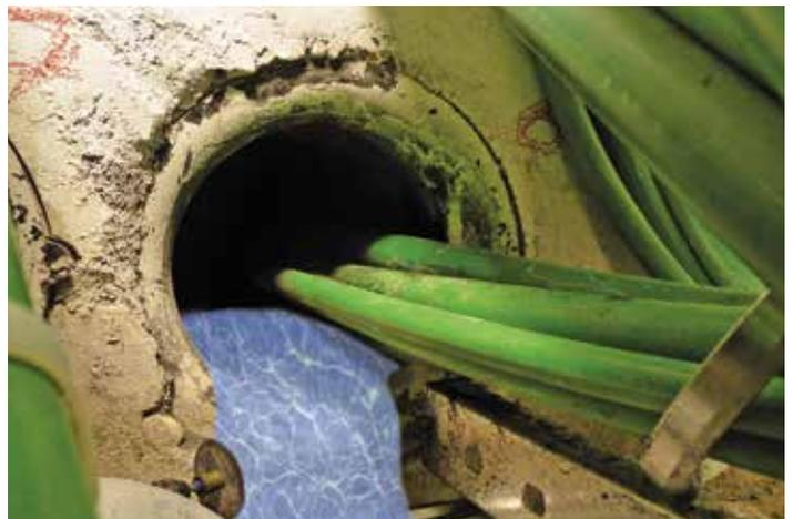
impermeabilizzazione con Guarnizioni Ex-Post, installate senza dover rimuovere i cavi.
