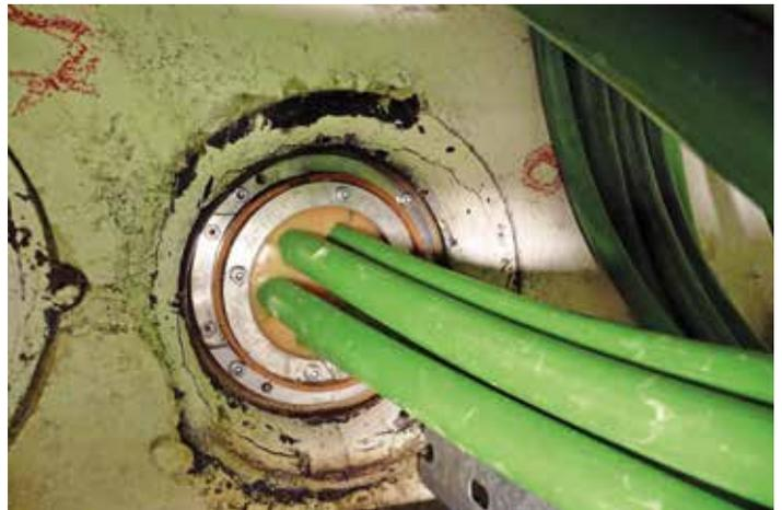
Pressioni superiori a 3 bar: doppia Guarnizione Ex-post con iniezione di resina espandente DRYflex.
