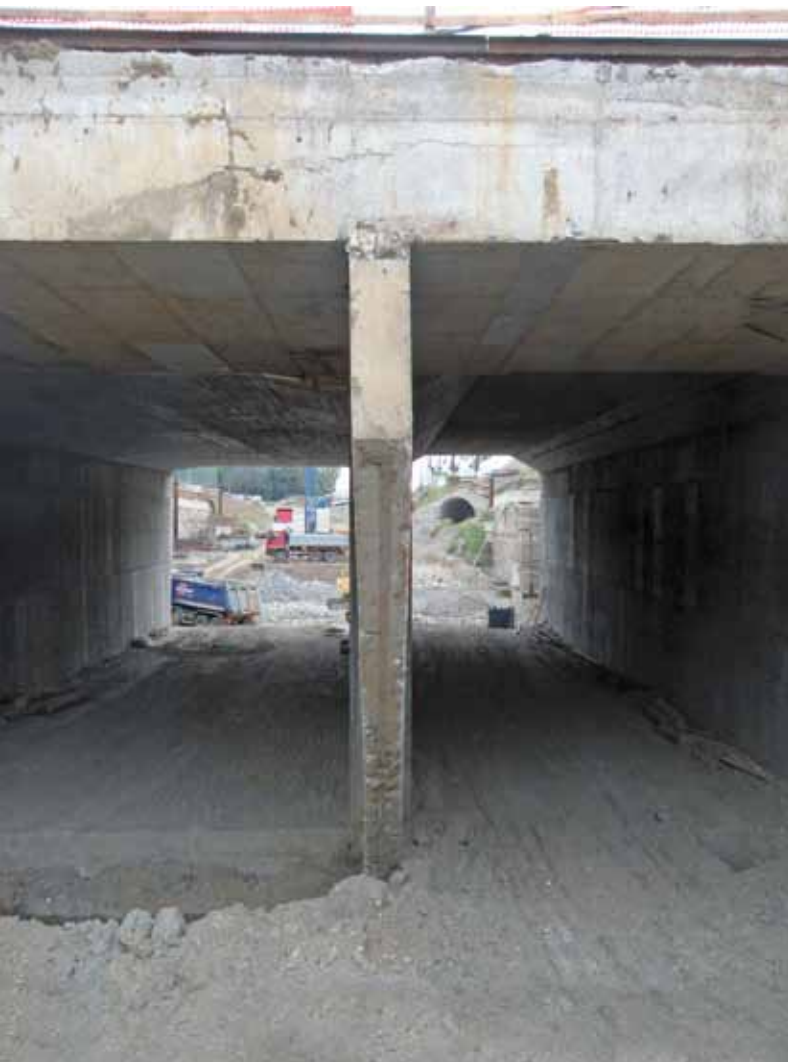
Nelle immagini a sinistra: una panoramica dello scavo a ridosso della massicciata e il monolite quasi completato. Qui sopra gli elementi di fessurazione programmata posati nell'armatura della parete e, a sinistra, il monolite nella sua sede, al di sotto della linea ferroviaria.
