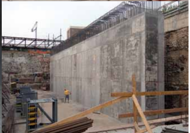
Nelle immagini a sinistra: una panoramica dello scavo a ridosso della massicciata e il monolite quasi completato. Qui sopra gli elementi di fessurazione programmata posati nell'armatura della parete e, a sinistra, il monolite nella sua sede, al di sotto della linea ferroviaria.
