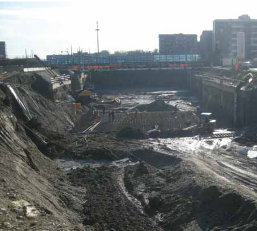
Sottopasso stradale di una linea ferroviaria, via Varsavia - Milano
