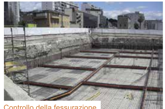
Controllo della fessurazione
