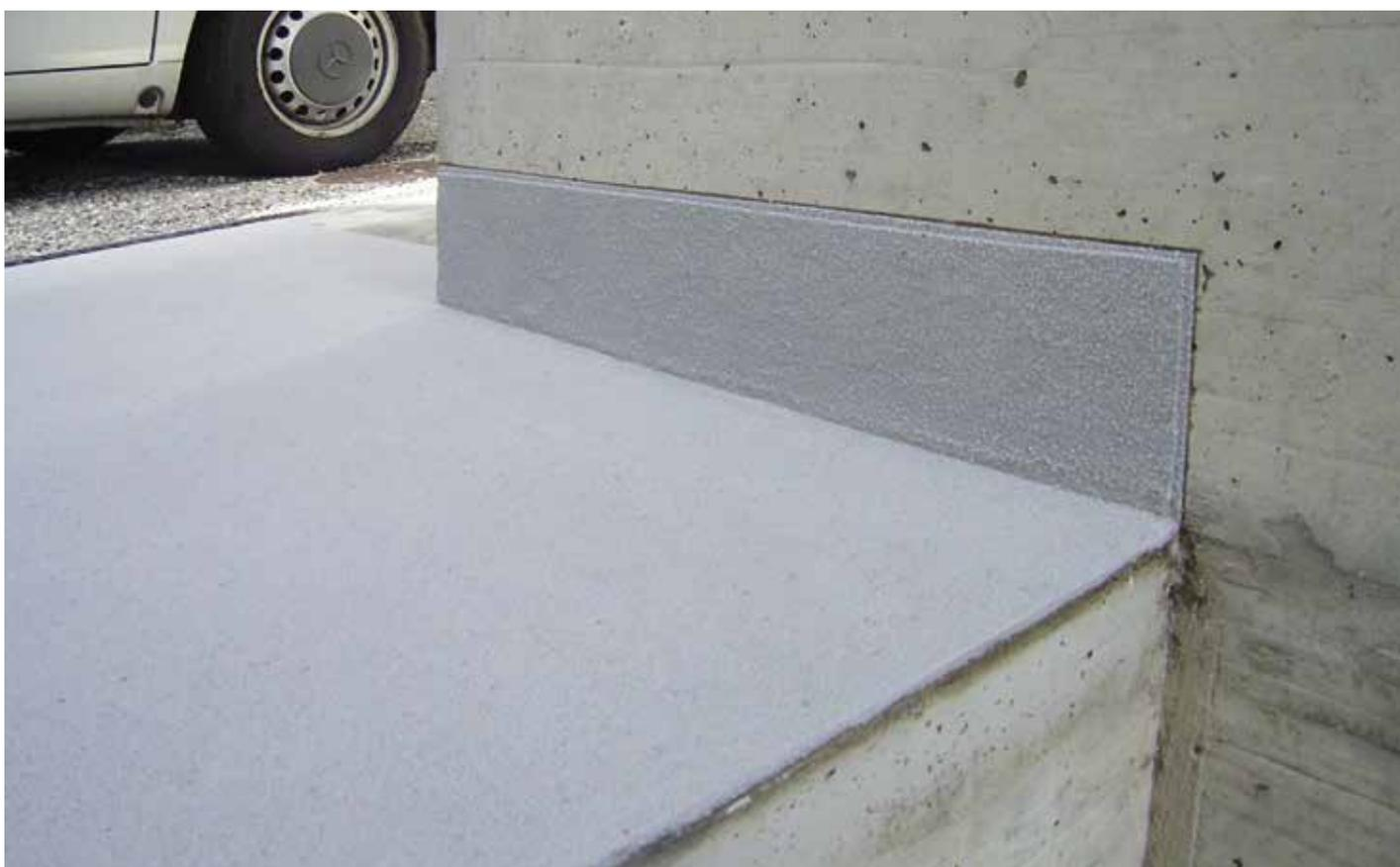
Nei risanamenti, Drycoat viene posato direttamente sulla superficie esistente, a cominciare dai particolari. A questi viene poi raccordata l'impermeabilizzazione della superficie.
