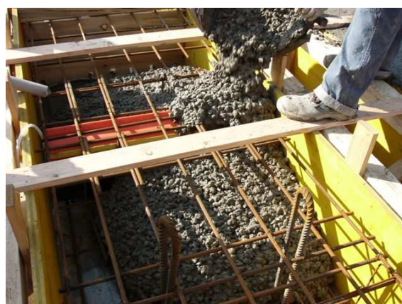
Figura 2.3-Dettagli armature e fase di getto.
