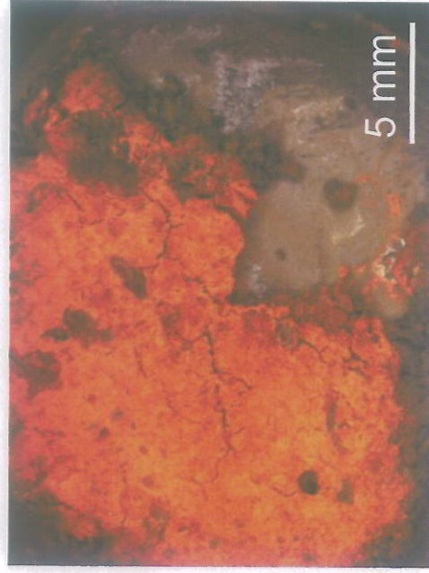
Strato di prodotti di corrosione sulla sezione superiore dell'armatura nella parte a contatto con la soluzione acquosa
