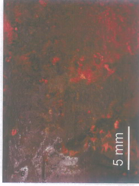
Forte corrosione dell'armatura nella parte a contatto con la soluzione acquosa
